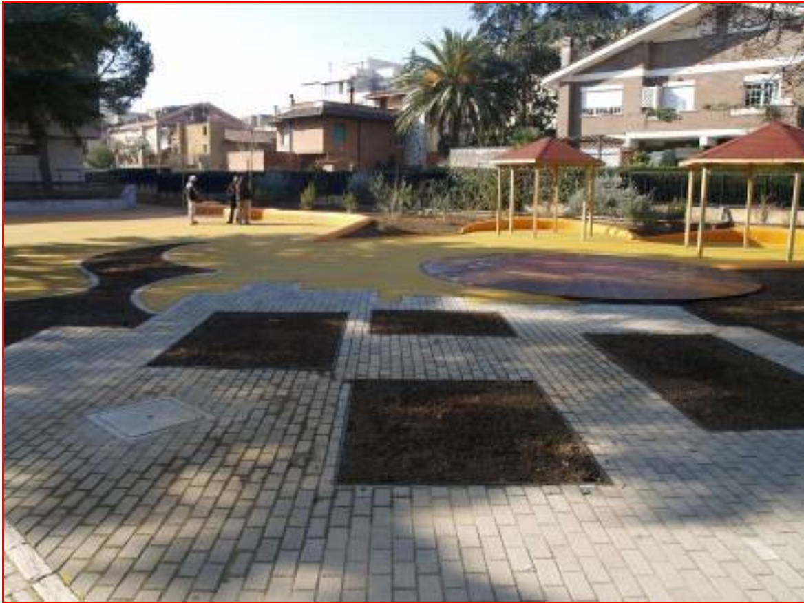
Istituto Comprensivo 'Parco di Veio' Roma: pavimentazione in betonella in cui sono ricavate alcune vasche di coltivazione
